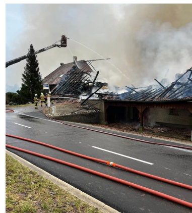
Weil sich beim Brandobjekt eine Postauto-Haltestelle befindet, muss wegen der Strassensperrung der Betrieb für 27 Stunden umgeleitet werden.
